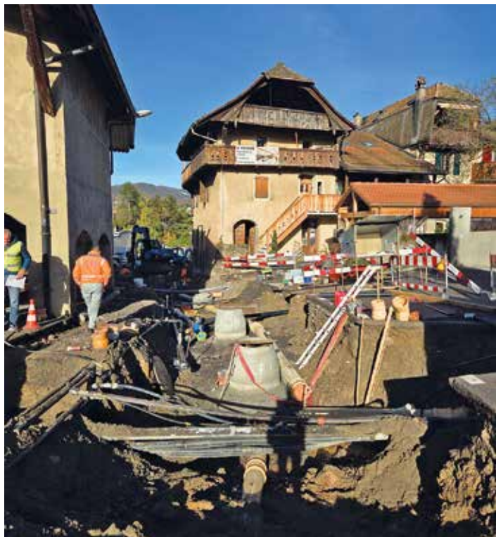
Les regards et les canalisations mis à nu.
