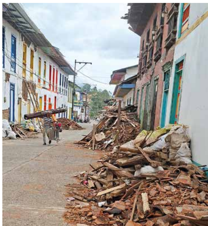
Les décombres dans les rues du village d'El Cairo témoignent de la violence du séisme.
