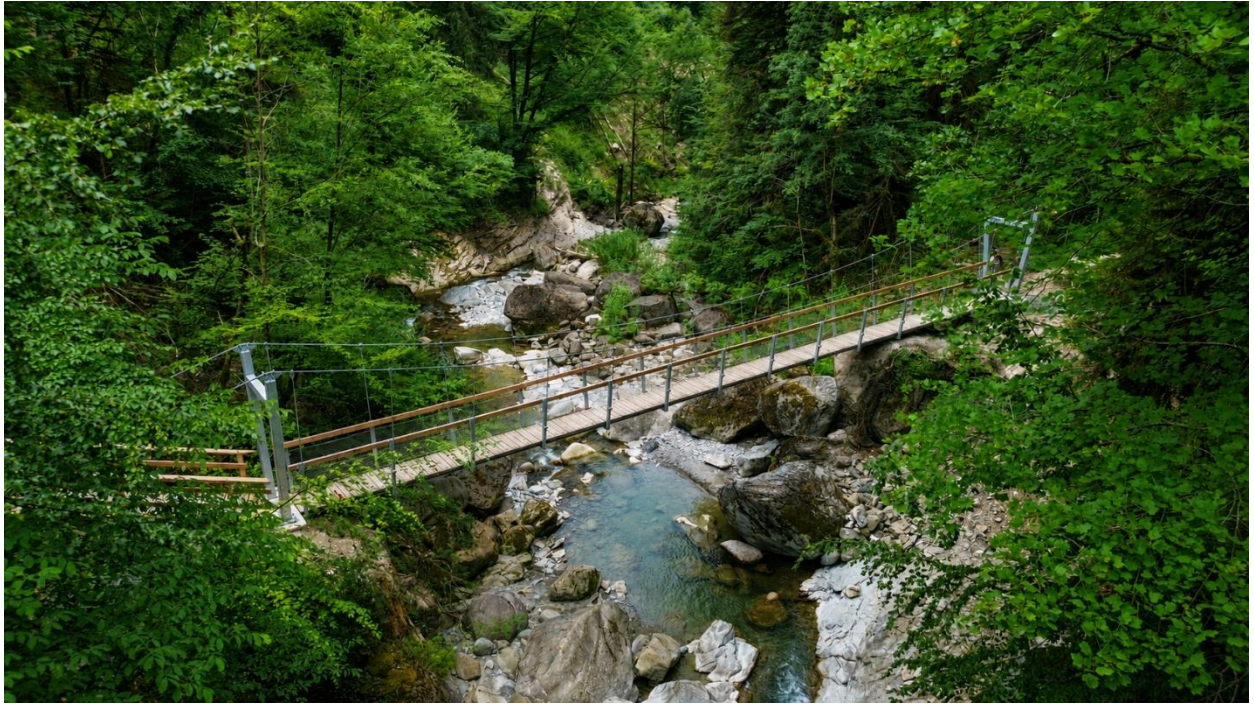
(La passerelle achevée)
