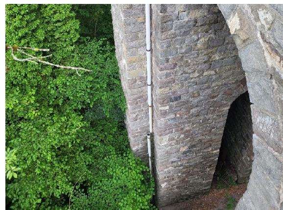
Figure 11 : Conduites d'évacuation des eaux déboîtées
