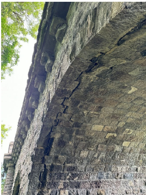
Figure 8 : Fissure de décollement du bandeau
