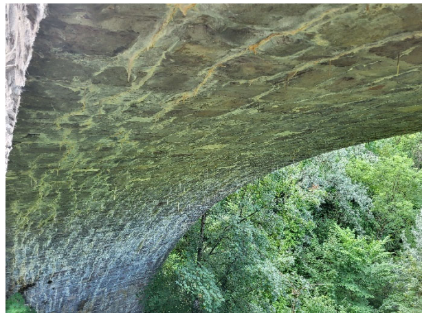
Figure 9 : Concrétions de calcite et venues d'eau actives à l'intrados de la voûte principale
