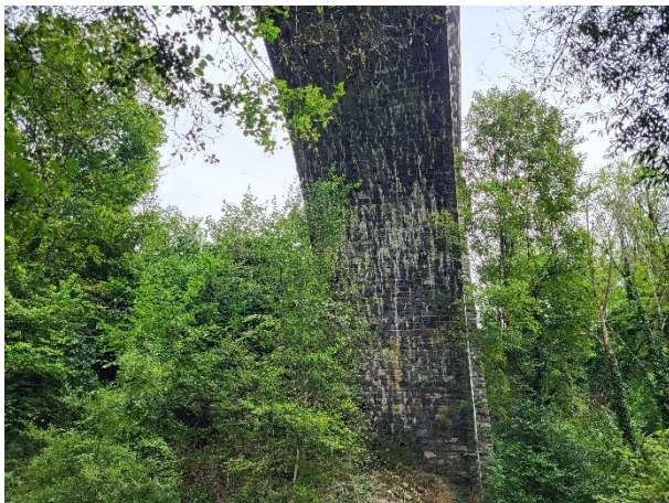
Figure 9 : Concrétions de calcite et venues d'eau actives à l'intrados de la voûte principale
