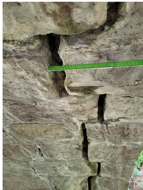
Figure 8 : Fissure de décollement du bandeau
