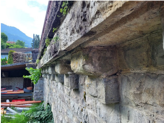
Figure 10 : Végétations et bordures détériorées
