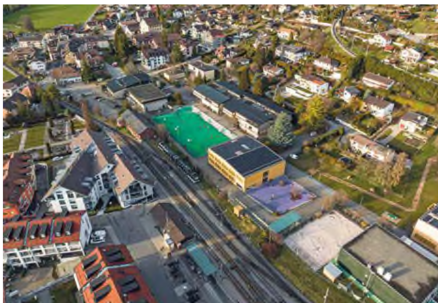
Vue sur le site scolaire de Bahyse.
