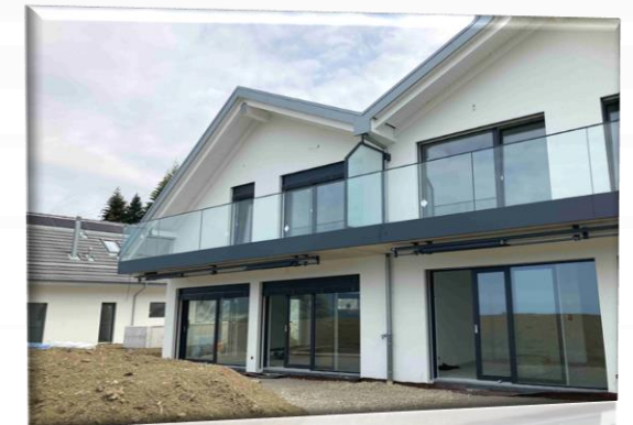
Construction d'une villa mitoyenne
