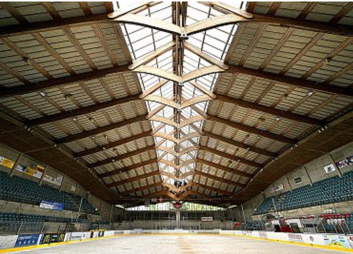
L'intérieur du bâtiment actuel, à assainir. Deux consortiums se penchent sur la question. CHRISTIAN BRUN
